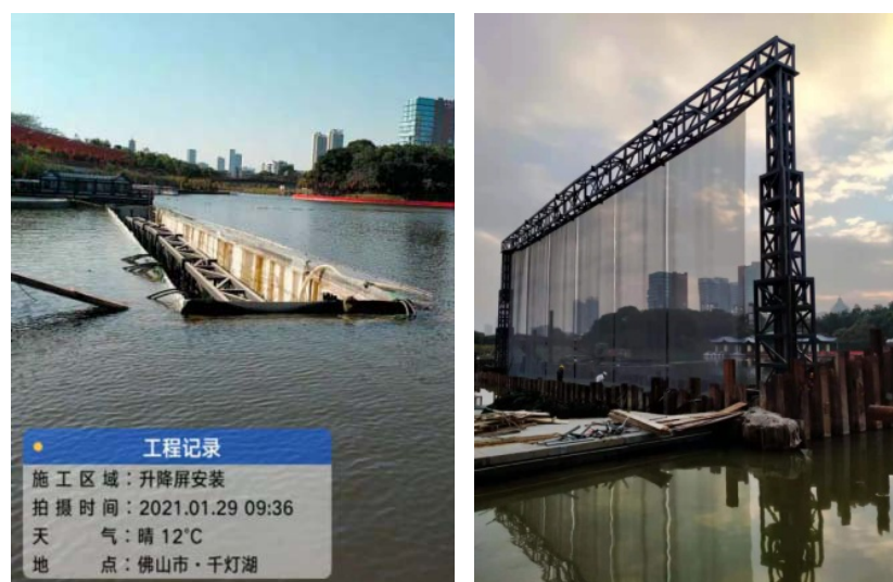
图 7-5、图 7-6 升降装置安装现场
